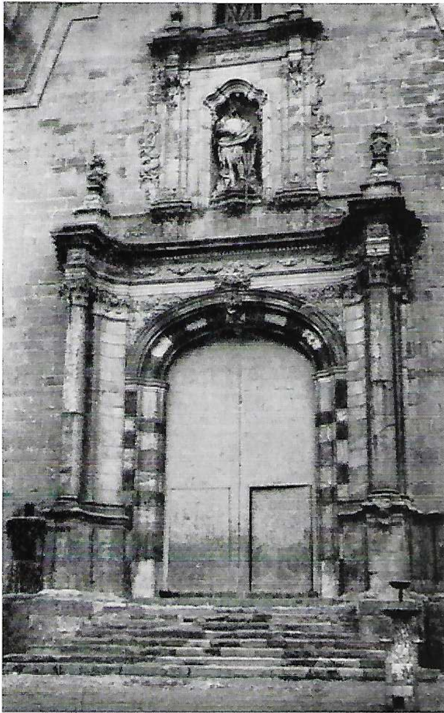
Portada de la Iglesia Parroquial de Cabanes. Los machones y dovelas del arco carpanel están hechos con bloques de mármol blanco y negro
