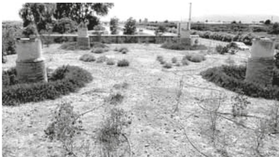
Fig. 7. Coberta depòsits d'abastiment. Les xemeneies en primer pla corresponen a la cisterna nord o superior on arribava l'aigua procedent dels filtres. Les dos xemeneies en segon pla corresponen a la cisterna sud o inferior que proporcionava l'aigua al municipi amb una pressió adequada.
